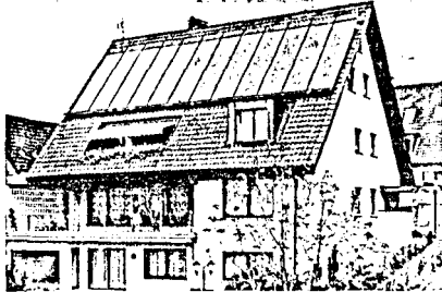
▲ Bild 3: Mehrfamilienhaus eines BfW-Bausparers in Essen, ausgestattet mit Dornier-Kollektoren, Wärmepumpe und Zwischenspeichern; vom RWE als Versuchshaus betrieben. Bild 4: Einfamilienhaus mit Dachteilen aus Pan-a-Therm-Absorbern, die als ENERGIE-DACH ausgebildet sind.
